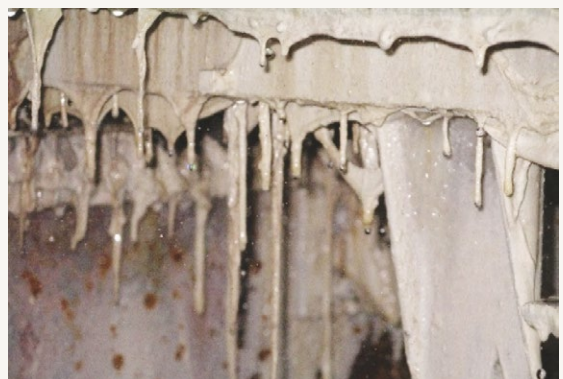
Foto 2. Biofilm in un pastorizzatore a tunnel per la pastorizzazione di bottiglie di birra.
